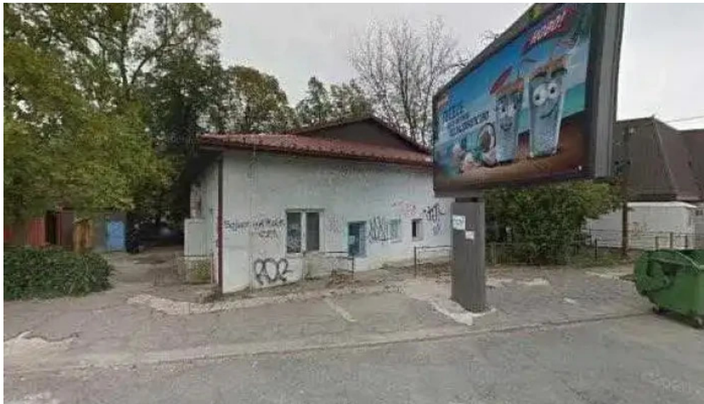
Vodovod i kanalizatsija punkt giorche petrov sie
