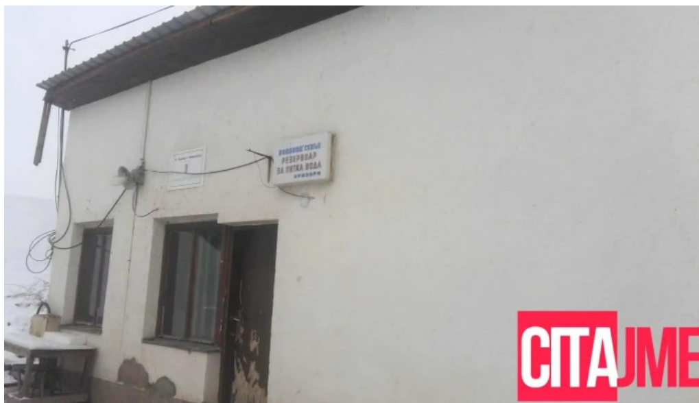
Jp vodovod i kanalizatsija skopje rezervoar shuto orizari sie
