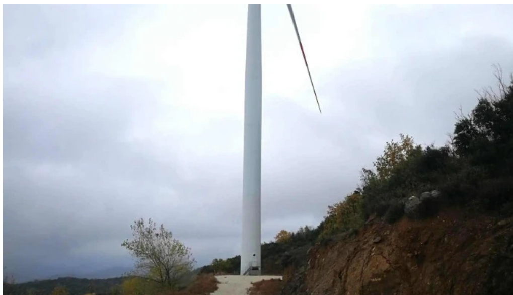
Park na veterni elektrani bogdantsi ?????????
