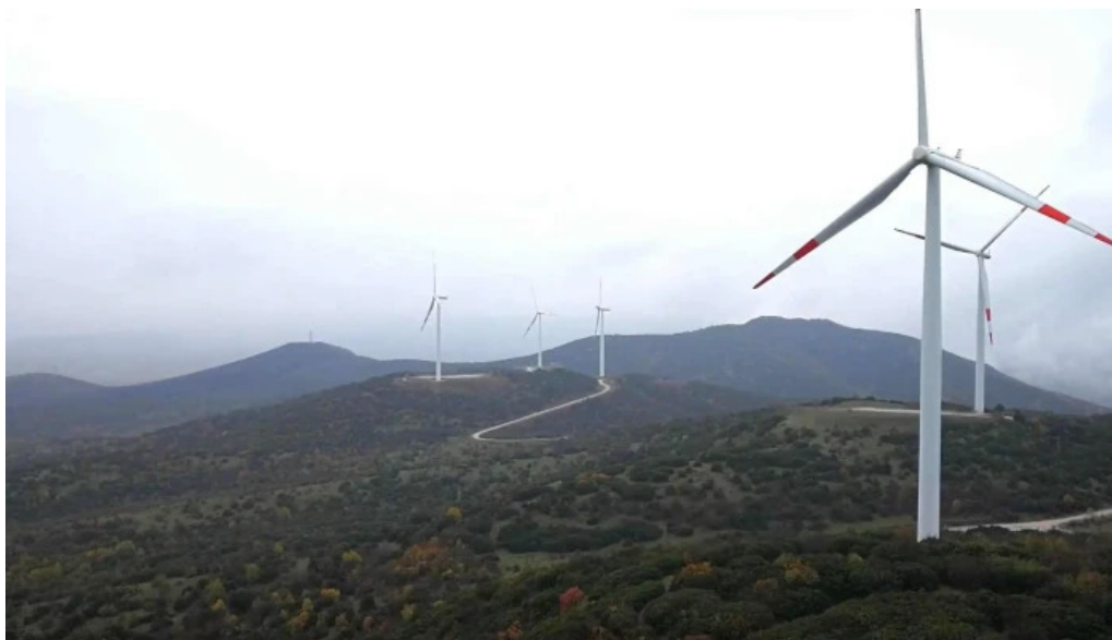
Park na veterni elektrani bogdantsi ????????
